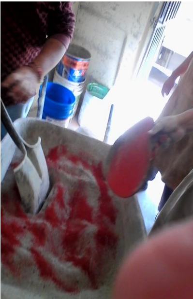
Fig. 15,- Preparado de mezcla para construir un modulo de para banqueta en tonos rojo y verde y blanco. Imágenes propias.
